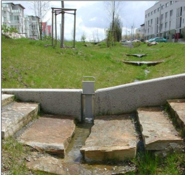
Figur 15. Exempel på dagvattendike med fördröjning i Kronsberg, Tyskland (Foto: Norconsult).
