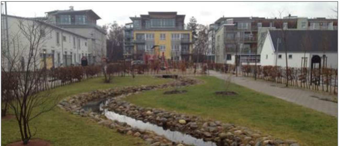
Figur 14. Exempel på öppet dike i Lomma (Foto: Norconsult).
